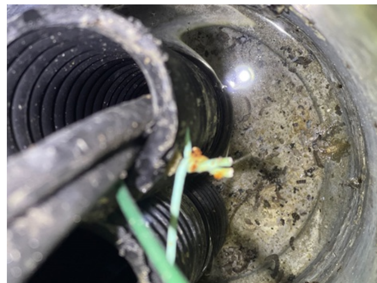
支柱内部の耐水
