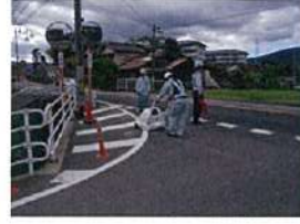
道路空洞探査、埋設管探査
