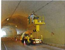
トンネル点検
