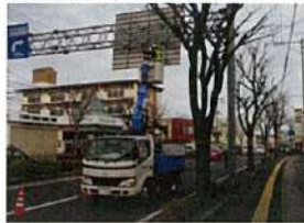
道路施設付属物点検
