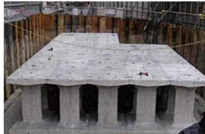
地下貯留槽 ハニカムボックス
