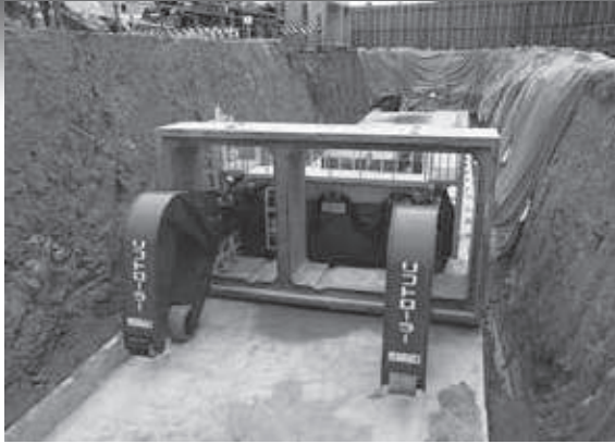
現場名:江波幹線共同溝 観音幹線共同溝 コンクリート製品搬送据付装置
