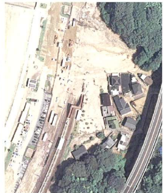
垂直写真の拡大例 (JR 水尻駅付近)
