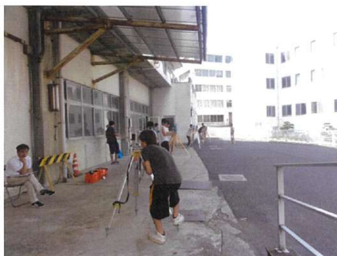
図1 三脚の据付の実技試験の様子
