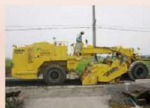
路上路盤再生工法 「スタビセメントRC工法」
